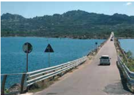
Arzachena (OT) – Ponte che unisce L'isola della Maddalena con l'isola di Caprera
