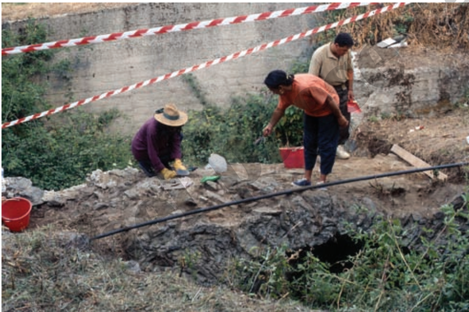
Volontari al lavoro sulla struttura del Ponte di Sofia
