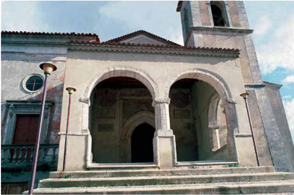
Santuario Madonna delle Grazie (sec XV) (ex Chiesa dell'Annunziata) - Facciata in stile gotico-durazzesco.
