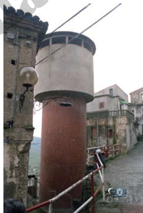
Manufatto che deturpa l'assetto architettonico e urbano del centro storico.
