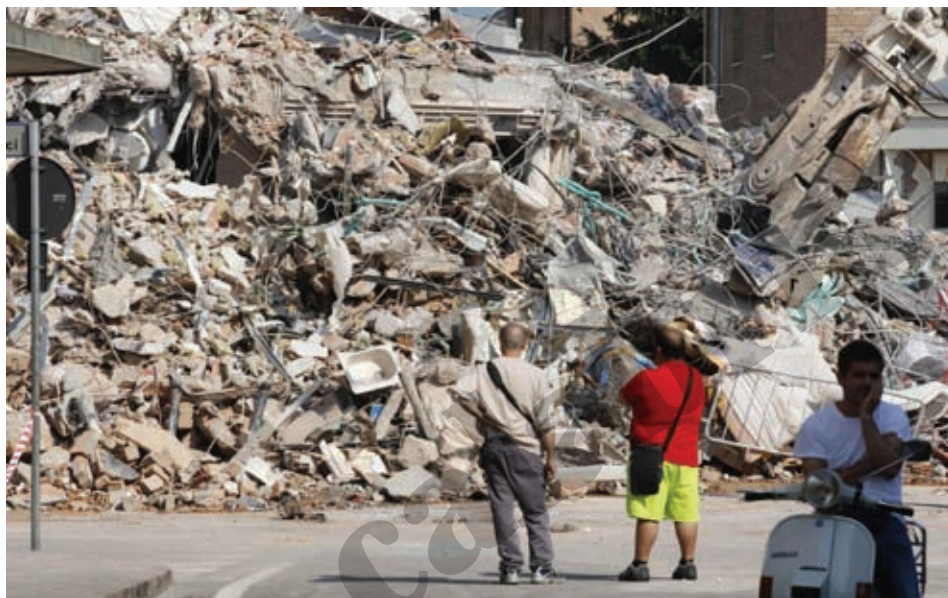
Un cumulo enorme di macerie, è lo spettacolo di questi giorni in tutti i centri dell'Emilia colpiti dalla furia distruttrice del terremoto.
